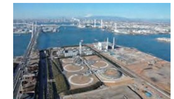
Ogishima LNG Terminal (Courtesy of Tokyo Gas Co.)
