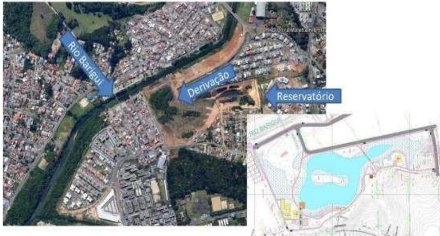
Figura 18: Reservatório de contenção de cheias em derivação do parque Guairacá Próximo à Rua Dionira Moletta Klemtz, bairro Fazendinha, Curitiba (2014). Fonte: Google, 2015. Adaptação: Schellin ,L, 2015.
